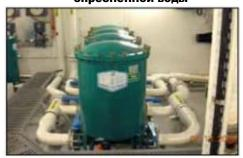
Четыре HIF 200FL-COAT корпусных фильтра были установлены для предварительной фильтрации обработанного осмоса морской воды на круизном корабле. Эти корпуса успешно справляются с задачей на протяжении последних семи лет!
