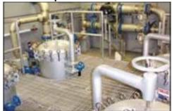
Четыре корпусных фильтра SB Hurricane® Swing Bolt были установлены параллельно, в качестве предварительной фильтрации обработанного осмоса, при использовании 5- микронных картриджей со скоростью потока 3,200 галлонов в минуту
