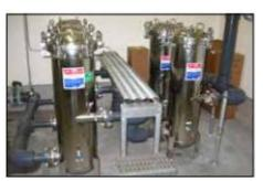
Один из заказчиков для небольшого сельского водоснабжения установил пять корпусных фильтров HUR 1x170FL, внесенных в список NSF-61, использующих два 5 мкм внесенных в список NSF-61 картриджей предварительной фильтрации за которыми идут три 1-микронных абсолютных картриджа.
