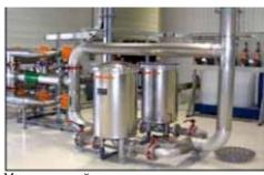
Международный завод по розливу воды установил два фильтра HIF 150FL в параллельном режиме с 1-микронными абсолютными картриджами оказывая охват материала в 2600 кв.футов, тем самым максимизируя площадь во время работы.
