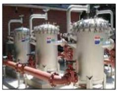
Фильтры Hurricane®, с картриджами для 20- и 5-мкм донных осадков (для предварительной фильтрации) и 1-мкм абсолютным номинальным значением картриджей Poly-Pleat<sup>TM</sup> для контроля уровня криптоспоридий. Результаты испытаний показали, что данные требования были достигнуты.
