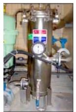
Фильтр Hurricane® устанавливается на градирне искусственной вентиляции. Твердые вещества удаляются, и клиент получает отчет, что фильтр может очистить свой картридж более 25 раз!
